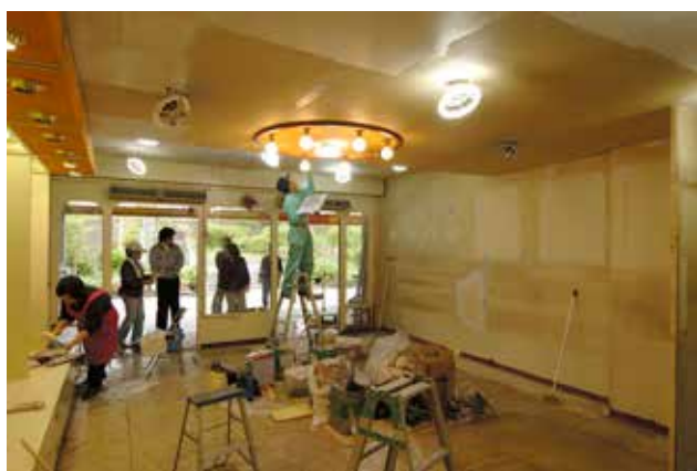
(写真 8-15) 「ひがしまち街角広場」の移転作業
