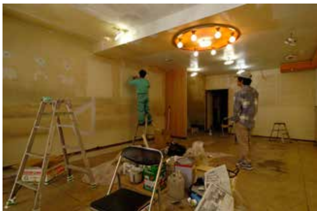
(写真 4-23) 移転作業の様子
