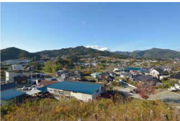
(写真 5-3) 「居場所ハウス」周辺の様子
