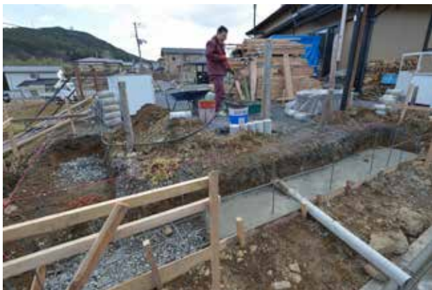
(写真 5-34) 屋外にキッチンを建設
