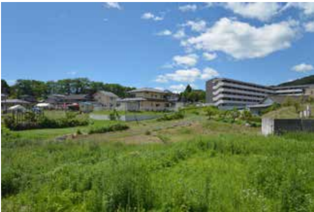
(写真 5-30) 災害公営住宅
