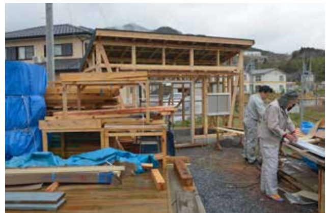
(写真 5-35) 屋外にキッチンを建設
