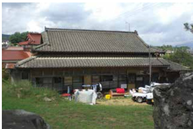
(写真 5-22) 移築前の古民家
