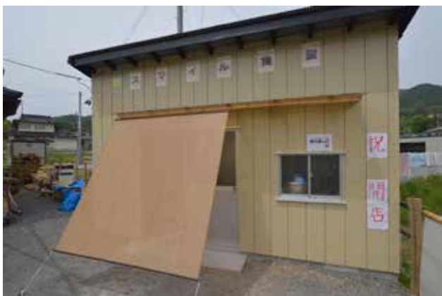
(写真 5-24) 屋外に建設したキッチン
