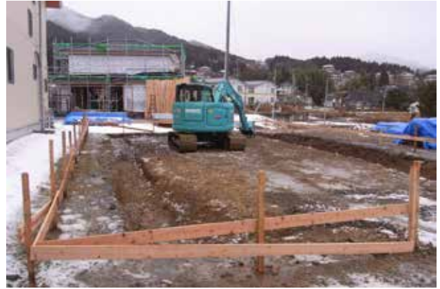
(写真 3-14) 建物の施工
