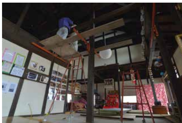
（写真 5-6）土間と和室の間の柱の撤去
