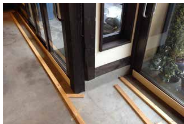
（写真 5-8）土間部分の浸水防止工事
