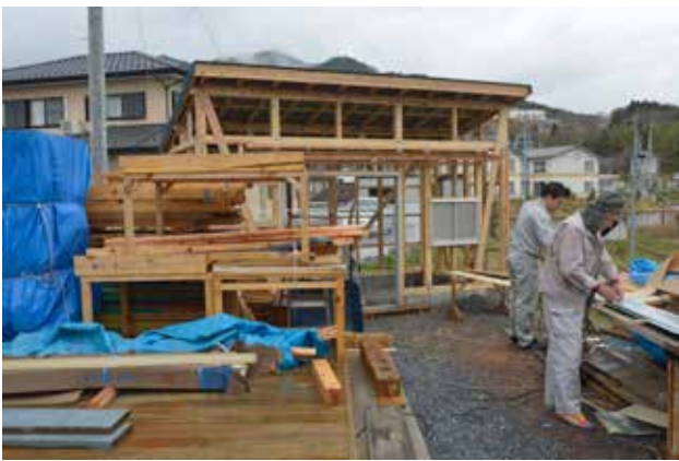
(写真 5-31) キッチンスペースの建築工事
