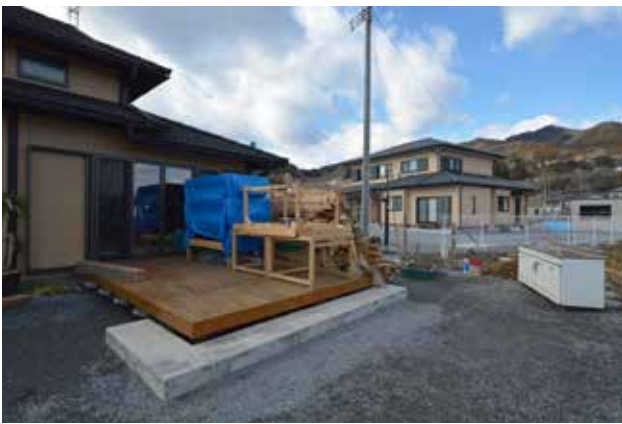
(写真 5-29) キッチンスペースの建築工事
