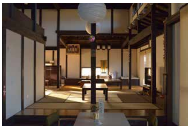
（写真 5-5）土間と和室の間の柱
