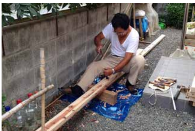
(写真 5-3) ロフトの物置にあがる梯子の制作
