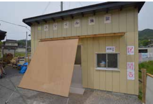
(写真 5-33) 完成したキッチンスペース
