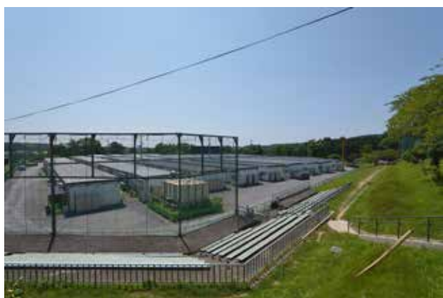
(写真 2-5) 大田仮設
