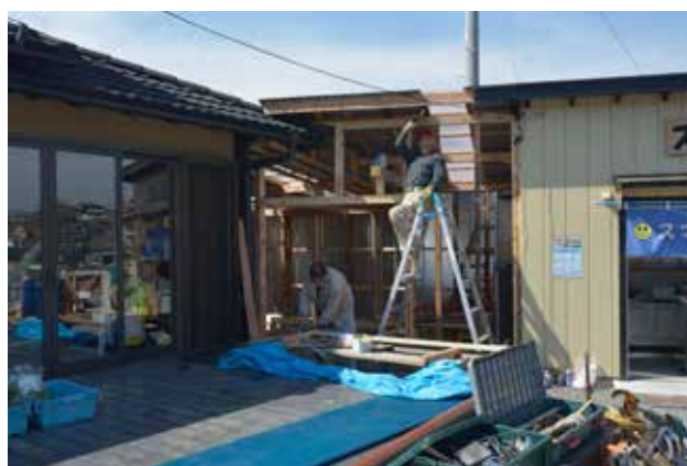
（写真 5-40）屋根付の通路の建築
