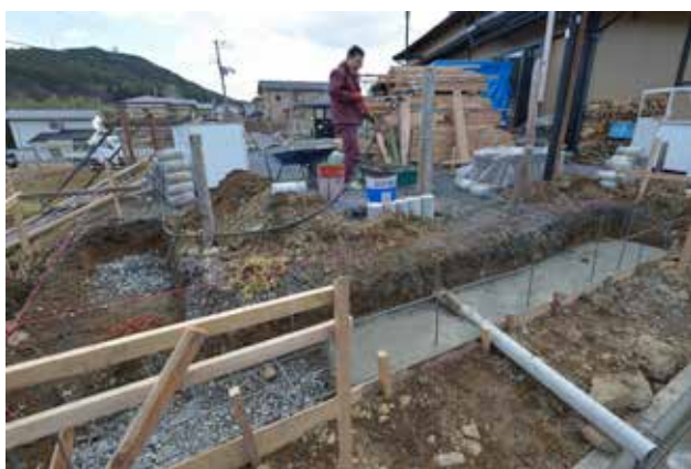
(写真 8-3) 屋外のキッチンスペースの建築
