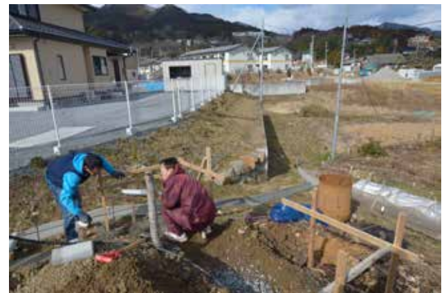
(写真 5-30) キッチンスペース建築のための資材
