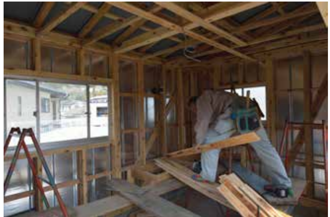
(写真 5-32) キッチンスペースの建築工事
