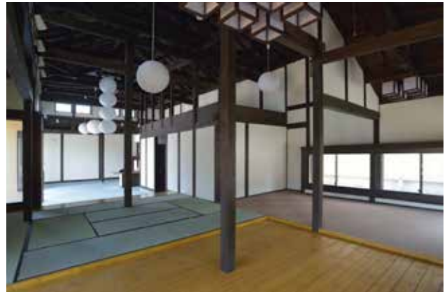
(写真 3-16) 竣工直後の居場所ハウス
