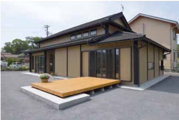
(写真 3-15) 竣工直後の居場所ハウス
