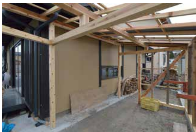
（写真 5-39）屋根付の通路の建築
