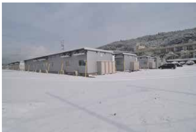
(写真 2-7) 山岸仮設
